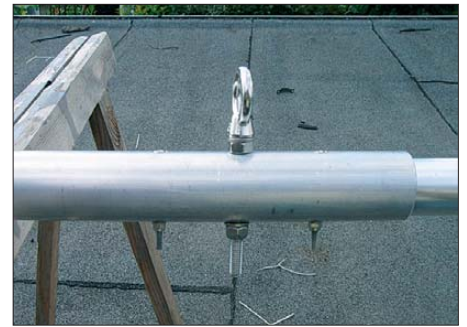
Bild 8: Um ein Durchhängen des Dipols zu verhindern, sind in diese Ösen die Abspannseile einzuhängen.
